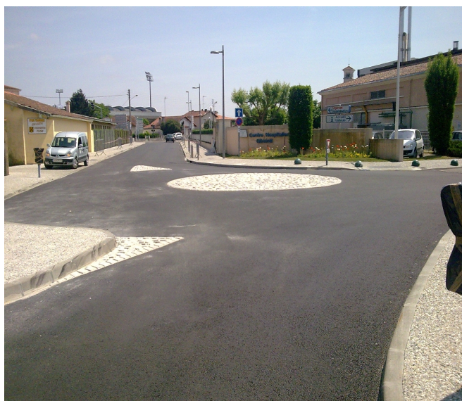
Exemple de giratoire franchissable (avenue Pierre de Coubertin)
