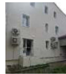
1, impasse de la Poste
