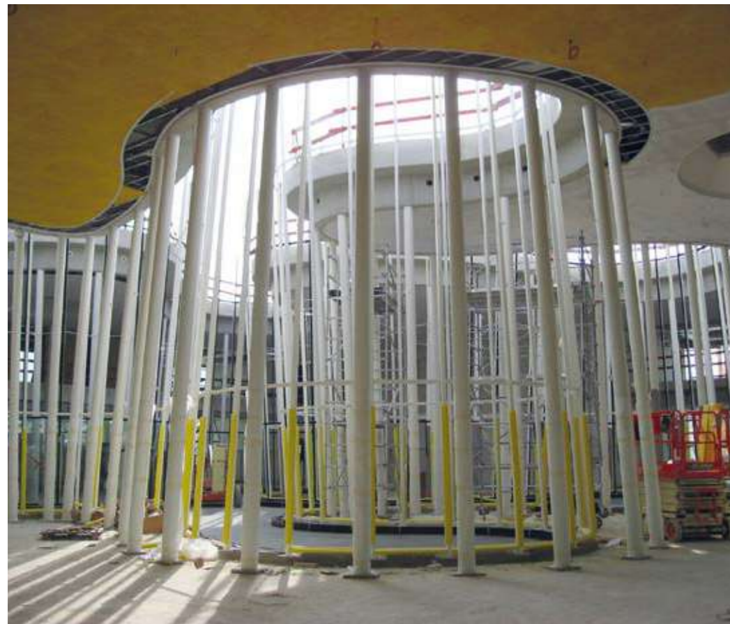
Visite de chantier
